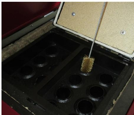
Para um bom funcionamento do equipamento, é essencial a limpeza com regularidade das cinzas que se depositam na gaveta.
